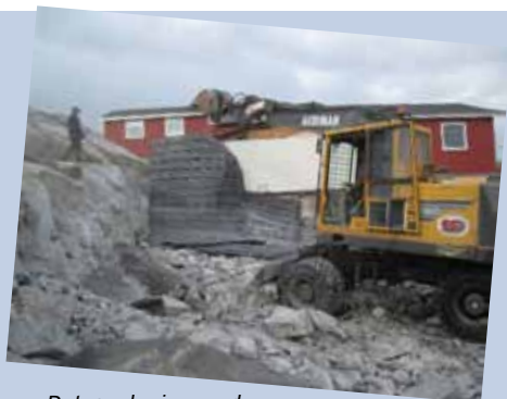
Det gamle rives ned...
